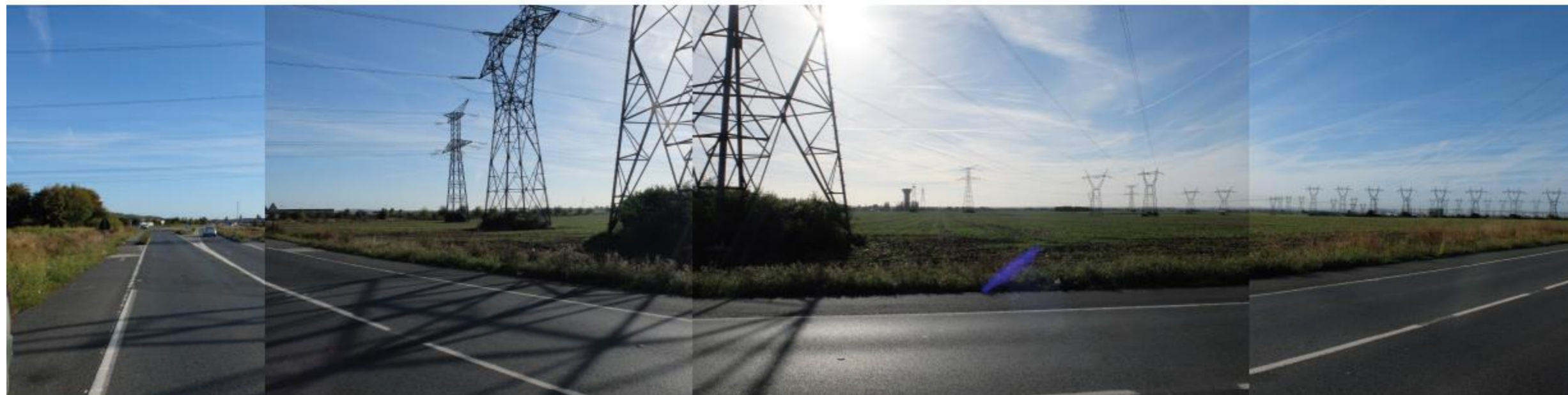
Lecture du paysage perturbé par la large emprise de la ligne électrique.
