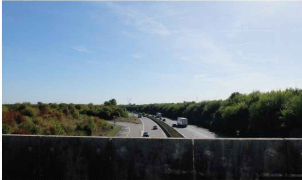
Francilienne en creux bordé de talus boisé de la Francilienne.
